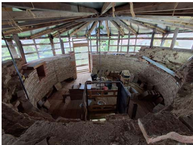
Le chantier du 2ème étage
