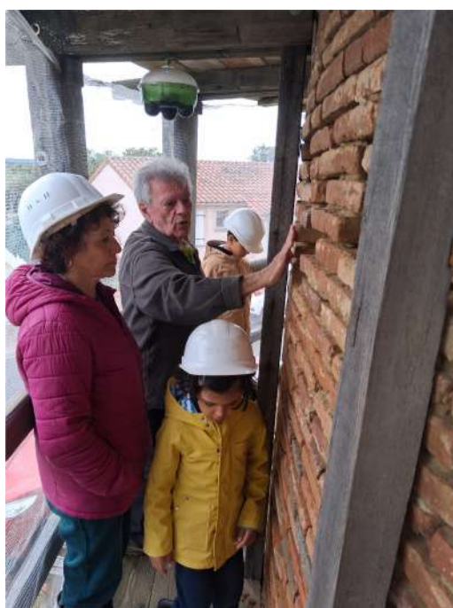
La visite par l'échafaudage organisée par Michel
